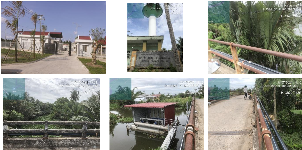
Một số hình ảnh hiện trạng cấp nước trong khu vực
