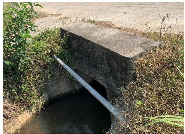
Đường ống cấp nước vào KDC
