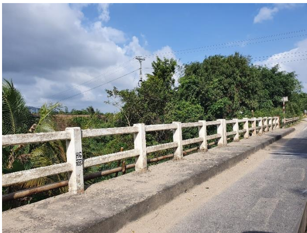
Đường ống trên đường Phạm Xuân Hòa
