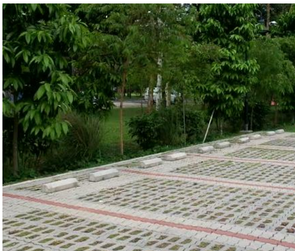
Hình 6. 8: Bãi đỗ xe sử dụng các vật liệu lỗ rỗng, cho phép thấm nước (trái) và bãi đỗ xe chống ngập – WSUD (phải)
