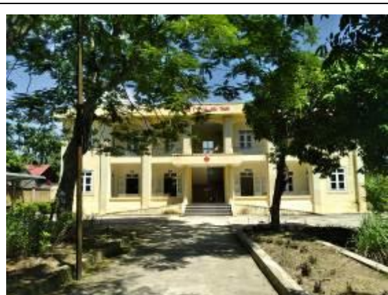
Trạm Y tế xã Nga Tiến
