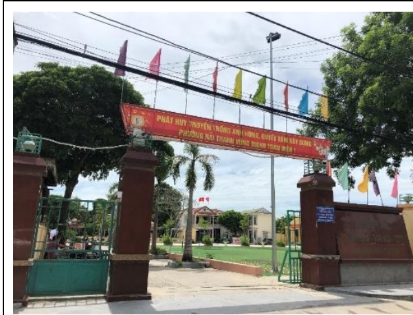
Công sở phường Hải Thanh
