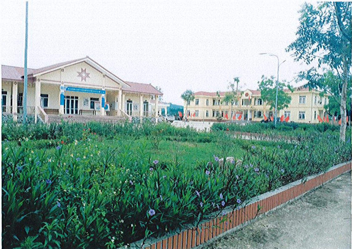
Công sở xã Phượng Nghi
