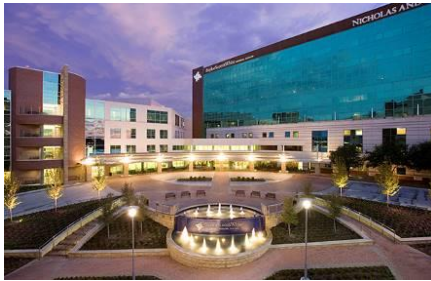
Hình 72: Tòa nhà hành chính
