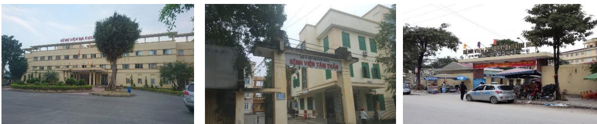
Hình 2.6: Hiện trạng công trình y tế
