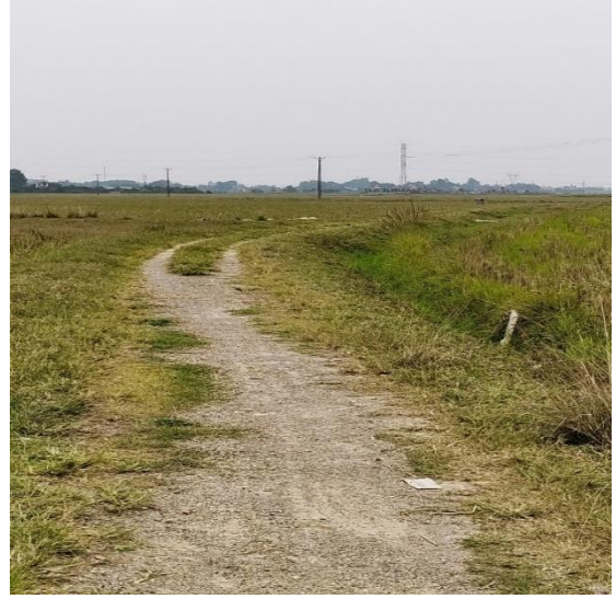
Hình ảnh: Đường giao thông nội đồng trên địa bàn xã
