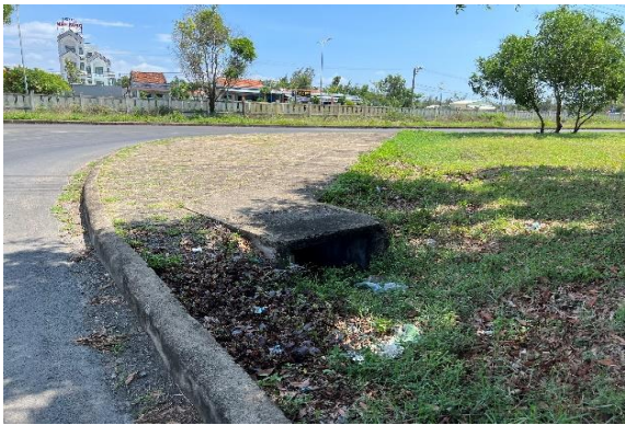
Một số hình ảnh hiện trạng hệ thống thoát nước mưa
