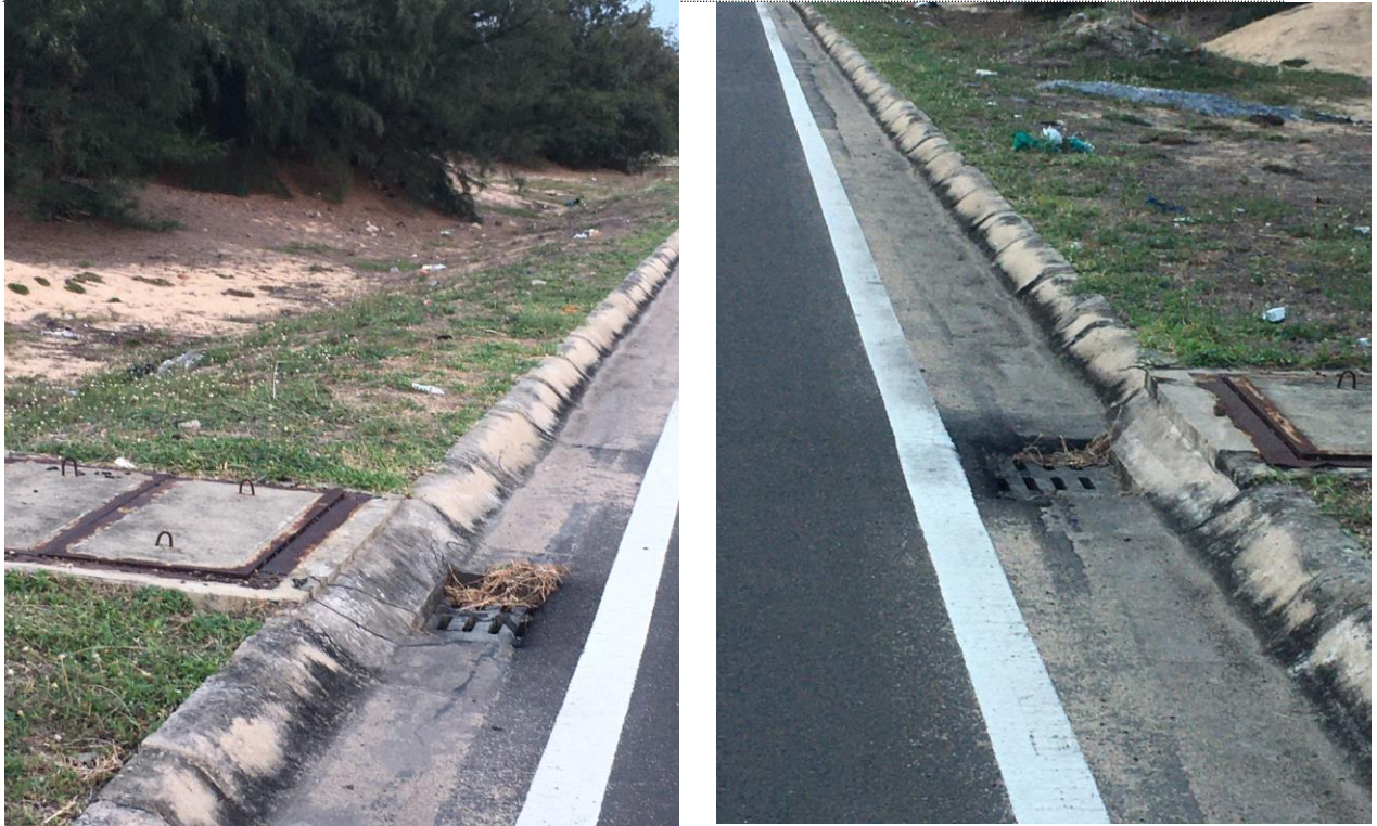
Hình ảnh hiện trạng hệ thống thoát nước mưa
